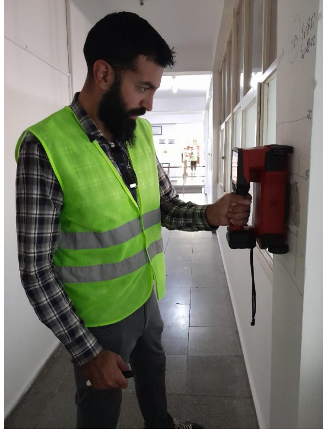
Şekil 13. Dikey yönde ana donatıların tespit edilmesi.
