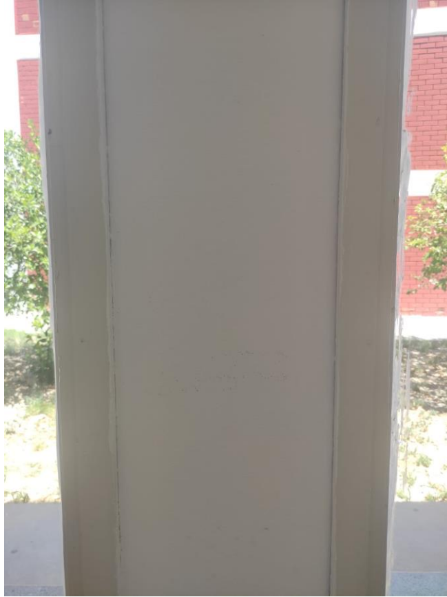
Şekil 22. İnşaat ve Çevre Mühendisliği Fakültesi giriş kat üzerindeki bir kolonun karot alım işlemi sonrası tamir edilmiş ve boyanmış görüntüsü.
