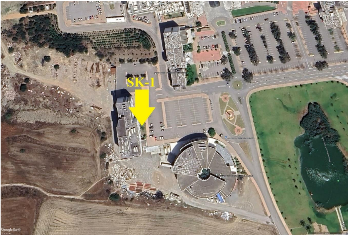
Şekil 41. Veterinerlik Fakültesi ve Hayvan Hastanesi'ne ait sondaj kuyusu lokasyonu.
