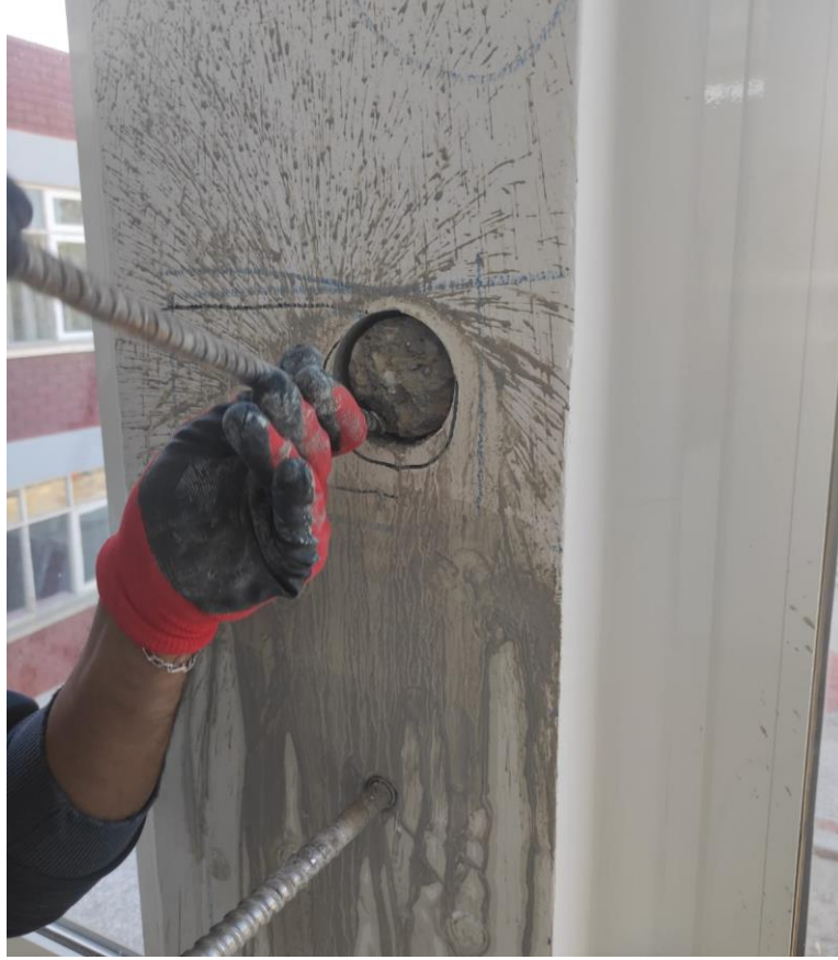
Şekil 20. Beton karot numunesinin kolondan çıkarılma işlemi.
