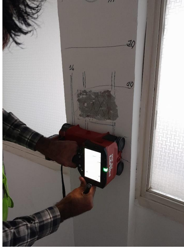
Şekil 15. Taşıyıcı eleman üzerinde karot alımı için en uygun noktanın tespit edilmesi ve işaretlenmesi.
