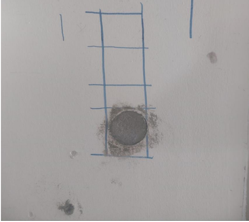
Şekil 21. Beton karotu alım işlemi sonrası tamir harcı uygulaması.
