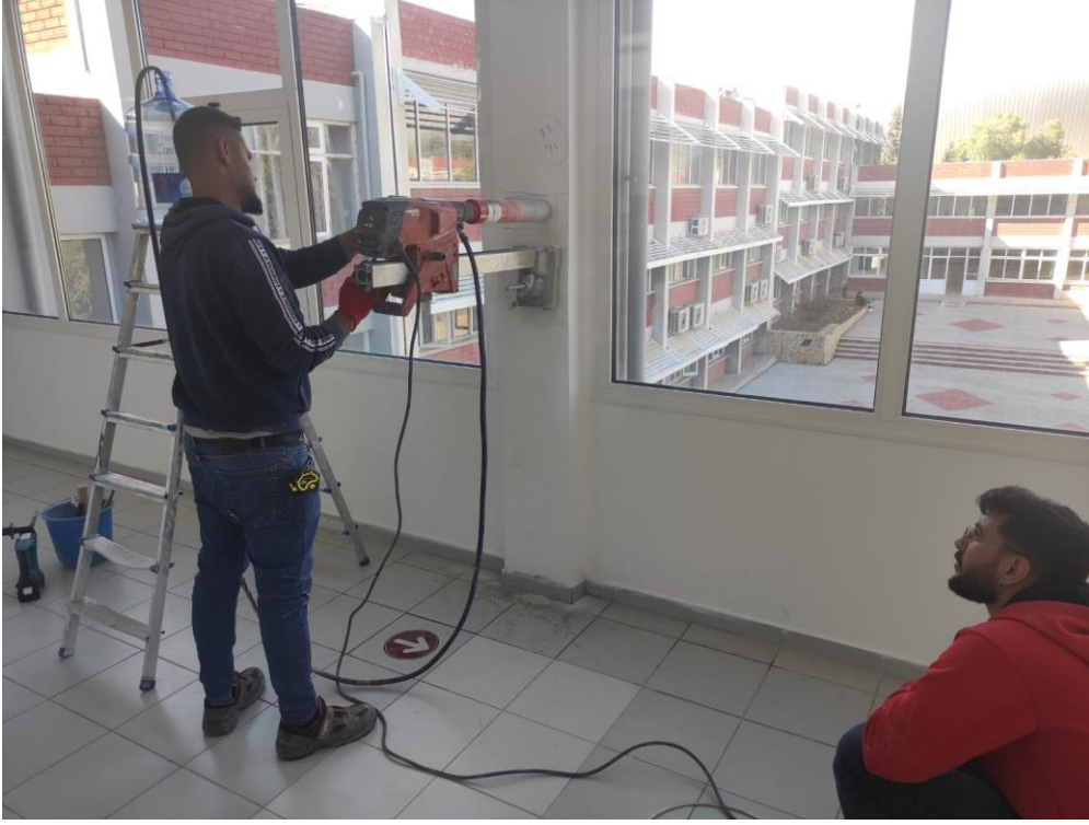
Şekil 19. YDÜ Lise 2. kat beton karotu alım işlemi.
